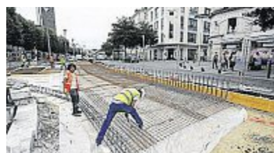
Des travaux cours des 50-Otages et la rue de Strasbourg saturée.
